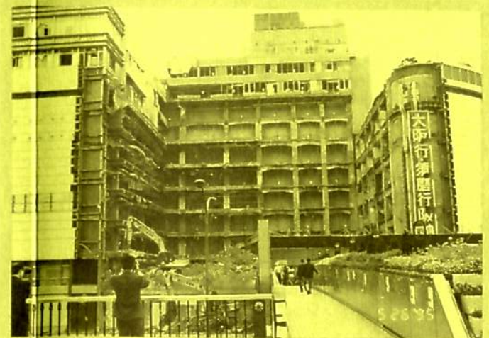
神戸の中心街・三宮では 被災したビルが次々と撤去されいく(5月26日)
