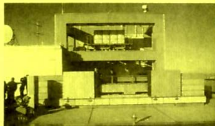
④「リバーサイド隅田」の制振装置
