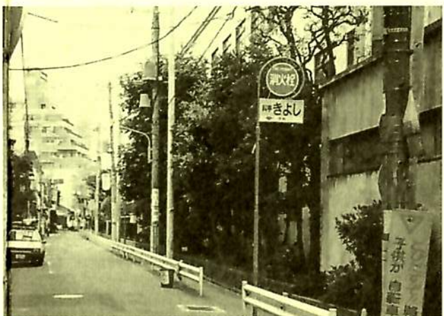
電柱の移設工事中の三とも通り。
