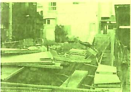
▲工事中の広場 この春完成予定
