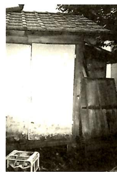
東向島三丁目、新川屋酒店裏(改装前に写す。現在は無い)
