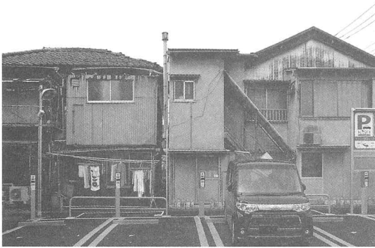
○検討課題の一つとして上がっている、老朽した長屋且つ空き家の例。
