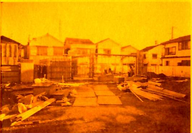
△コンクリートの型枠がたちあがる (10月20日撮影)
