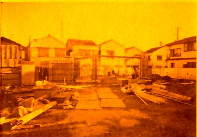
△コンクリートの型枠が立ちあがる (10月20日撮影)
